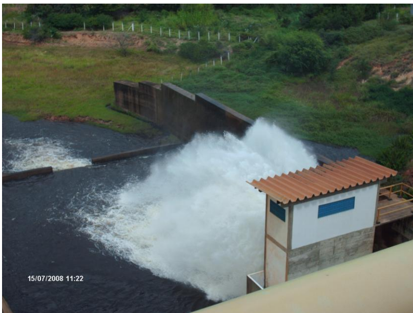
Figura 8.3 - Barragem de Ponto Novo Nota: Visita de campo, julho 2008.
