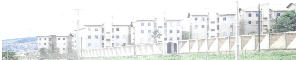
Foto 18 - Entrada de um condomínio fechado em Vitória da Conquista
