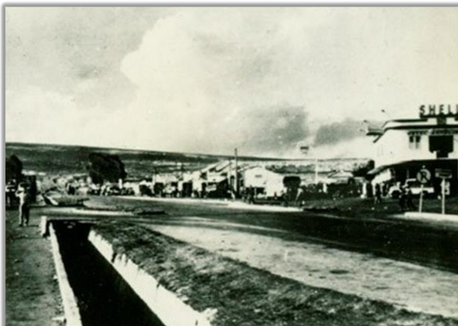
Foto 8 - Avenida Presidente Dutra, localizada no Bairro Centro
